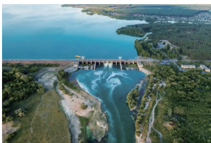
水电站安全检测
